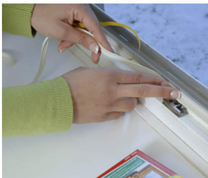
Richtiges Anbringen der Dichtungsbänder
