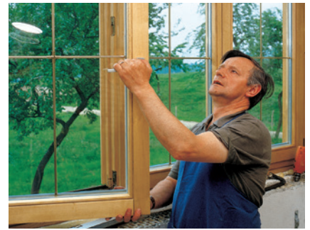
Das Einsetzen neuer Fenster ist eine einfache Maßnahme, die innerhalb eines Tages zu erledigen ist.
